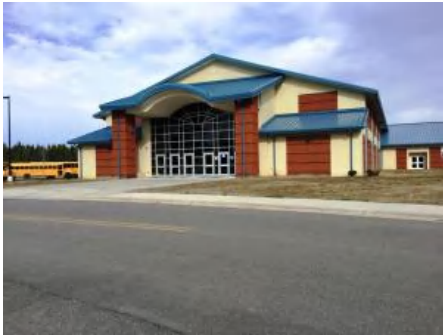
4). West Elevation - Feb 08, 2017
