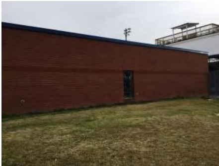
4). West Elevation - Feb 08, 2017
