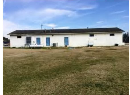
3). West Elevation - Feb 08, 2017
