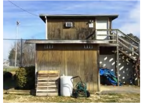
3). West Elevation - Feb 08, 2017
