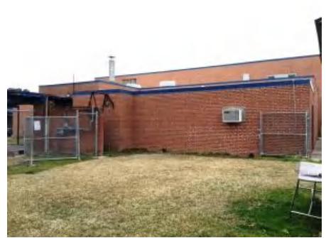
3). West Elevation - Feb 08, 2017
